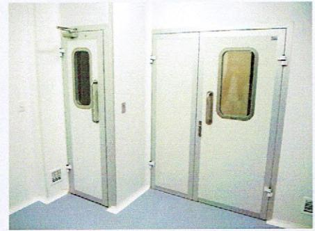
La configuración de la puerta de abatir sanitaria **Indalce**, es en base a un diseño geométrico de cierre, que permite dar una solución sanitaria de **sello doble contacto**, de cantos curvos y sin burletes ni felpas contaminantes.
